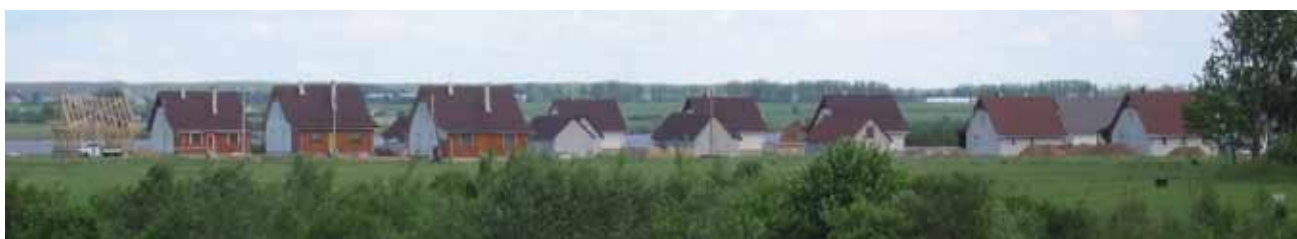
Наши партнёры – общественные организации «Дома вместо Чернобыля» и «Экодом» построили в районе ряд энергоэффективных домов на принципах устойчивого развития
